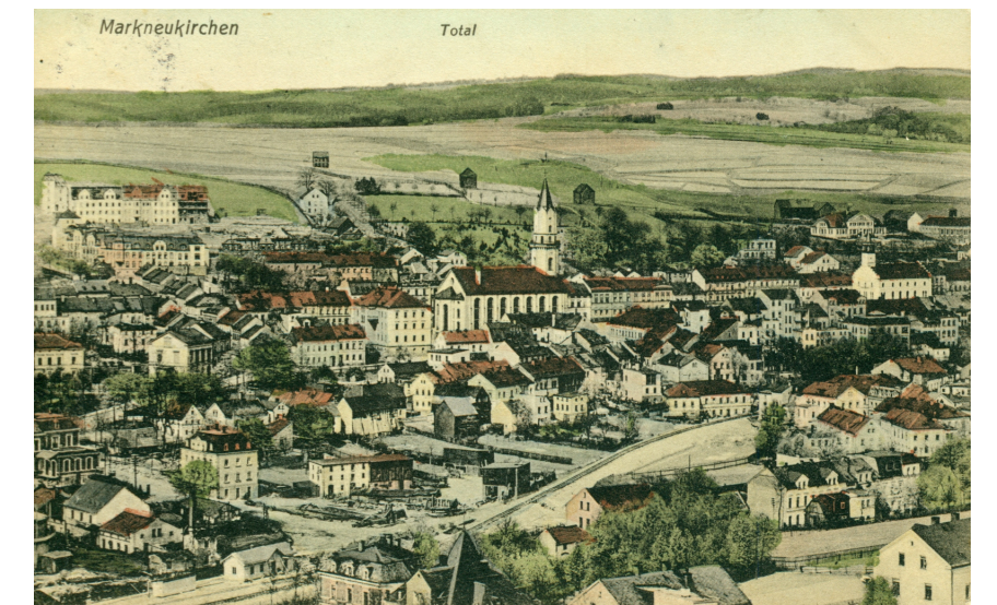
Mosenstraße oben links im Bau, 1908
