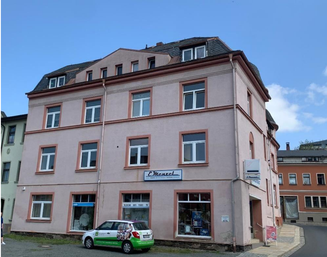
Hausansicht – Eingang Krumme Straße
